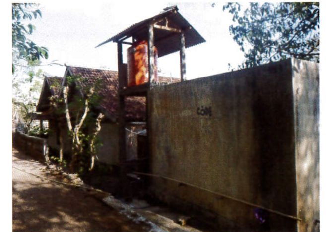
CODEによって施設された水道タンク
