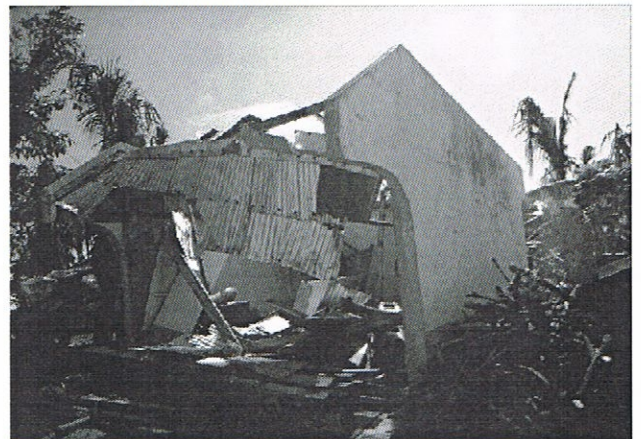
倒壊した家屋（バンタヤン島にて）
