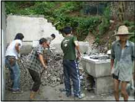
瓦礫撤去作業を行うボランティアたち
