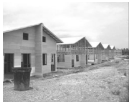
住宅の建設(スチールフレーム住宅)の支援が終了しました。(建設中の住宅 2006年8月)
