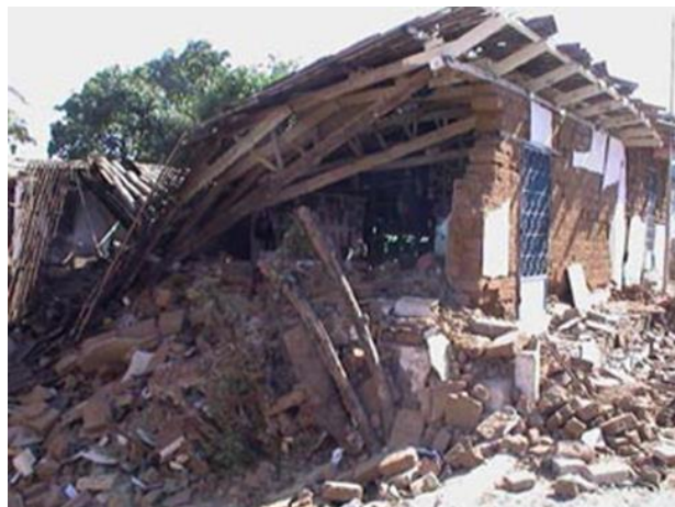
↑地震により倒壊した家屋
