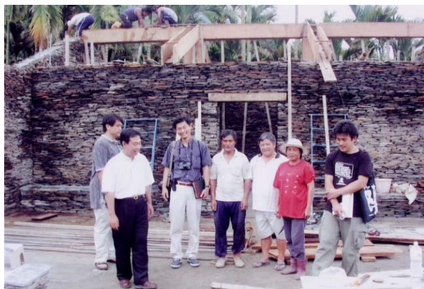
先住民ブノン族の文化センター建設（潭南村）
