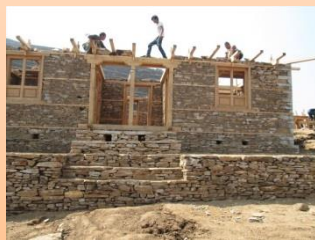
耐震住宅再建支援 (ネパール)
